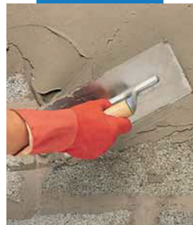
Нанесение Planiseal 88 (Планисил 88) кельмой
